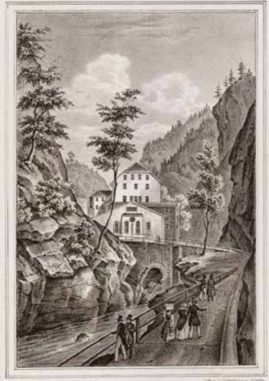
DER BADEPFLÄFER von der Südseite.
