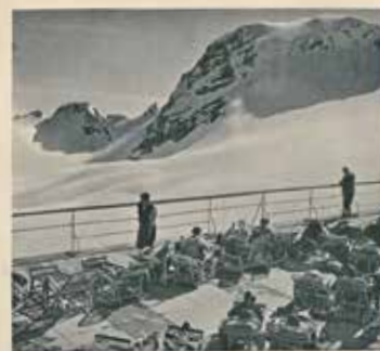
Loggenhaus des Schneehauses 2600 m. ©29 phm
